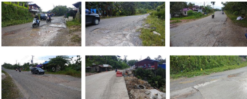
Gambar 1.2 Jalanan Rusak Di Jalan Poros Makroman
